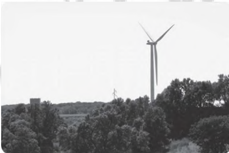
شکل ۲-۱- یک توربین بادی مدرن ۱/۶۵ مگاواتی (برج به ارتفاع ۸۱ متر)
