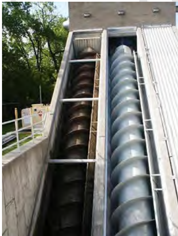
شکل ۱-۱ پیچ ارشمیدس برای انتقال آب به سطحی بالاتر
