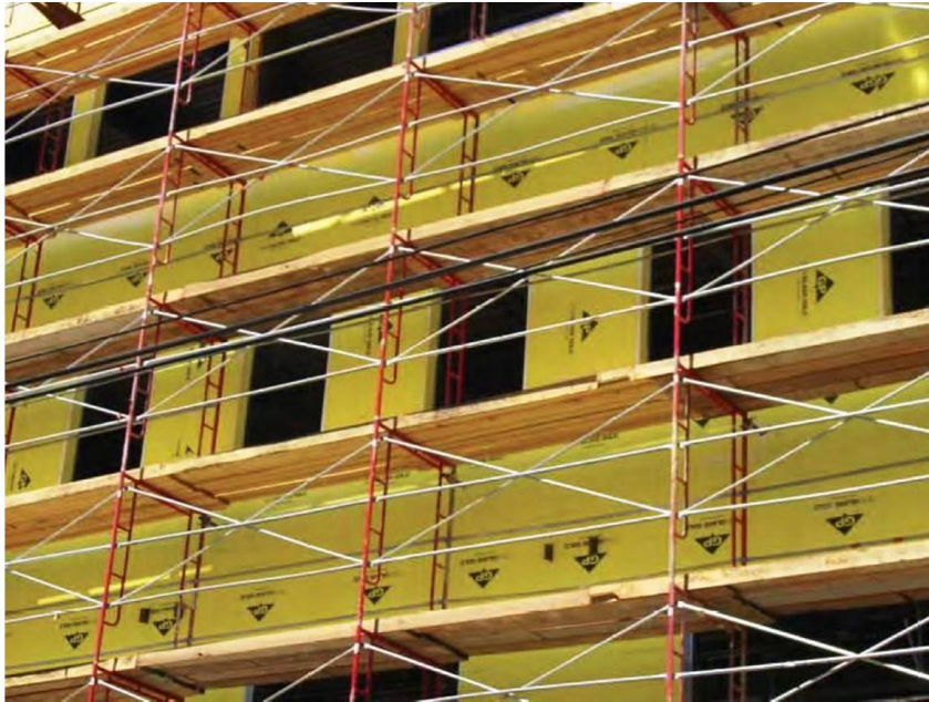
شکل ۴-۱: استفاده از داربست قابی پیش ساخته جهت ساخت نمای ساختمان چندین طبقه
