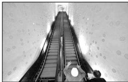
نمونه پله برقی با شیب 26.5^\circ
