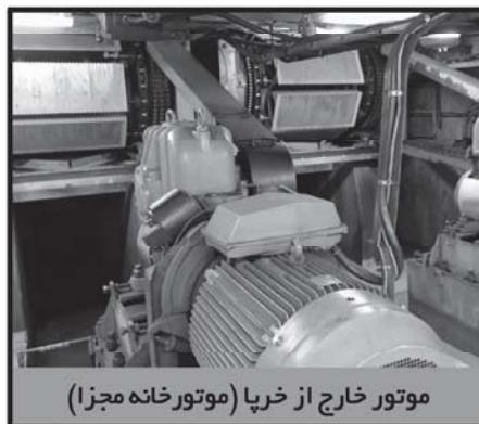
درخصوص راه اندازی موتور در صورتی که کیلووات آن کم باشد (حداکثر ۵/۵ کیلووات) از راه اندازی مستقیم و برای کیلووات‌های بیش از ۵,۵ کیلووات از راه اندازی ستاره مثلث استفاده می‌گردد. امروزه با متداول شدن استفاده از راه اندازی توسط درایو ۳VF توصیه می‌گردد کلیه موتورهای الکتریکی برای کاهش مصرف انرژی و نیز کاهش استهلاک از نوع راه اندازی درایو استفاده گردد.
