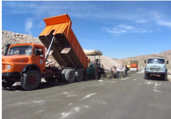
شکل ۱-۲. تخلیه و پخش بتن غلتکی روسازی
