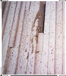
شکل ۷-۱ پریدگی لبه‌های سنگ
