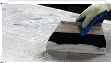
شکل ۲-۳ اجرای رزین جهت پر کردن خلل و فرج سنگ
