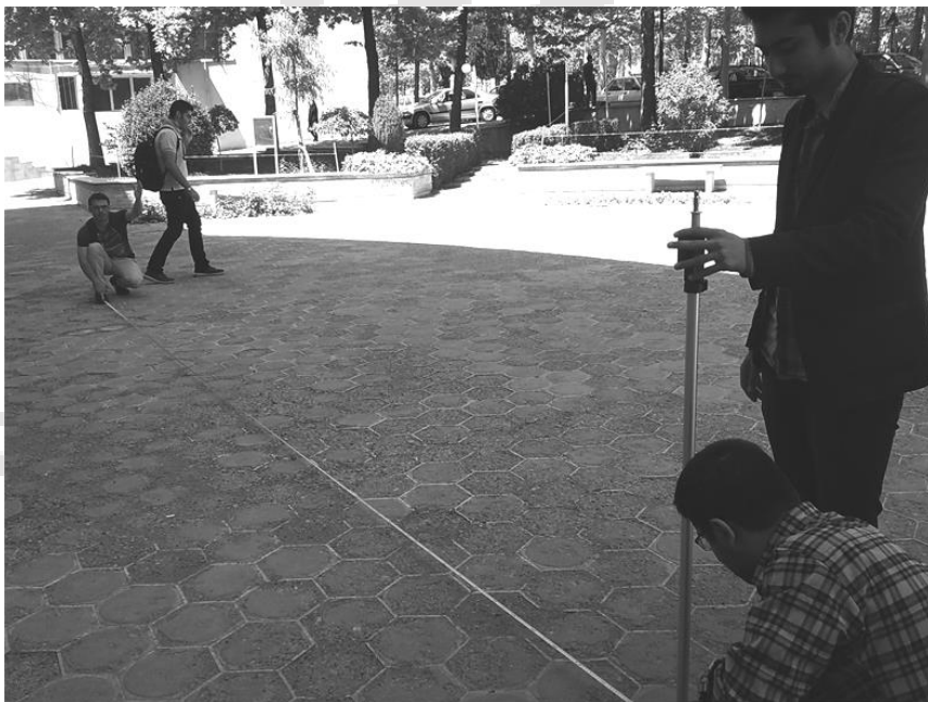
شکل ۱-۲ نحوه اجرای عملیات مترکشی
