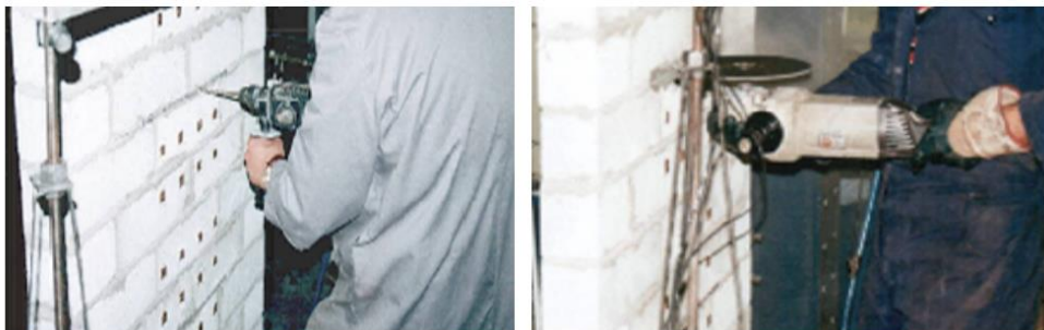
شکل ۱-۴-الف نحوه ایجاد شکاف برای تعیین مقاومت فشاری دیوار بنایی
