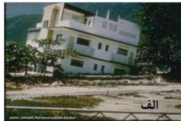
شکل ۲. الف) فرو رفتن یک ویلا بعد از روانگرایی درون خاک (ب) فرو رفتن یک ماشین کوچک و
