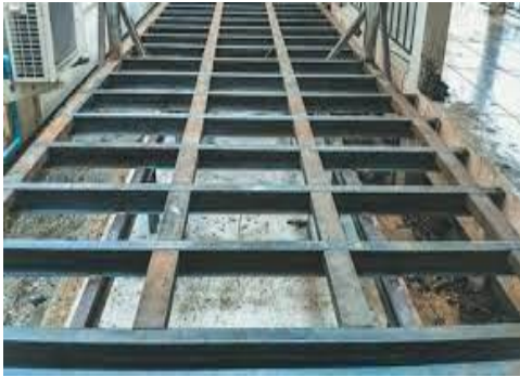
شکل شماره ۱-۱- پی فولادی
