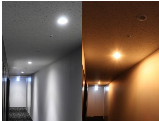
روشنایی عادی و روشنایی ایمنی راه خروج
