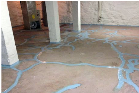
شکل شماره ۱-۱- ترمیم ترک بتن با اپوکسی
