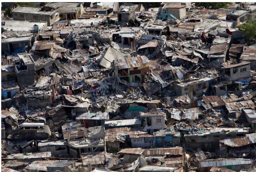
شکل ۱-۹ زلزله سوماترا، اندونزی ۲۰۰۴
